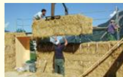
Budowa z użyciem kostek „jumbo”. Za zgodą: www.atelierwernerschmidt.ch
