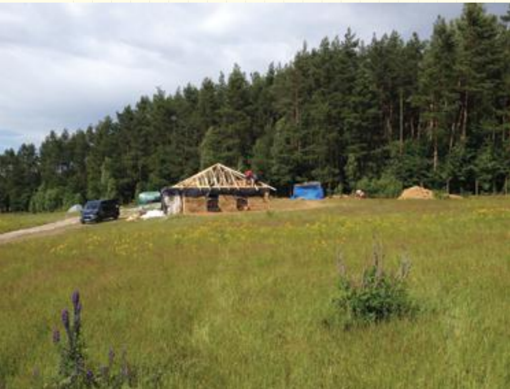
Widok domu strawbale loadbearing na pomorzu. Zdjęcie: Dan Jagucki.
