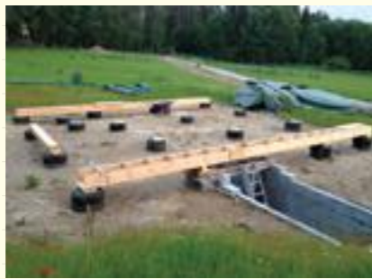
Widok fundamentów punktowych z opon. Zdjęcie: Dan Jagucki.
