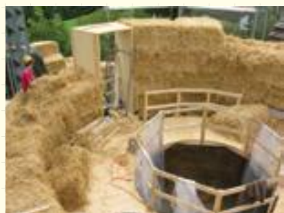
Ściany samonośne ze słomy. Za zgodą: www.atelierwernerschmidt.ch
