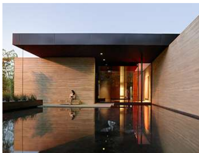
Zdjęcie 12. Budynek z gliny ubijanej
