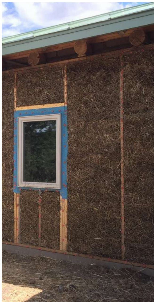
Zdjęcie 16. Konstrukcja wypełniona lekką gliną
