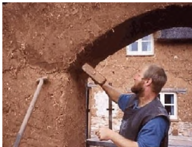
Zdjęcie 13. Wznoszenie ściany w technologii gliny układanej (cob)
