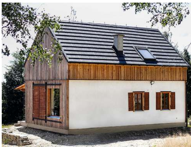
Zdjęcie 8. Dom w Kotlinie Kłodzkiej (2015–2017). Widać połączenie elewacji wentylowanej z desek oraz tynków wapiennych. Proj. eKodama Studio
