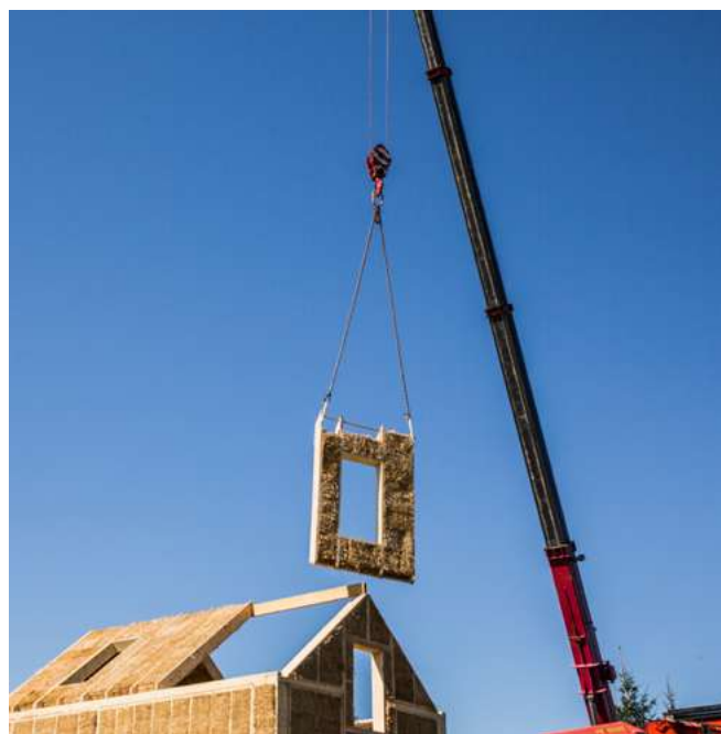
Zdjęcie 7. Budowa "Kryjówki Strawbale" 35m2. Proj. eKodama Studio, Magdalena Górską
