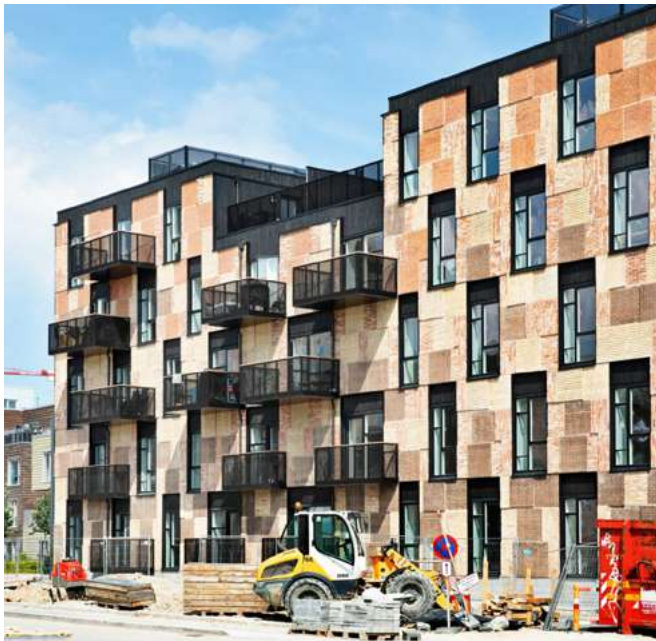
Zdjęcie 1. Rozbiórkowe cegły użyte jako materiał wykończeniowy prefabrykowanych ścian elewacyjnych w budynku w Kopenhadze
