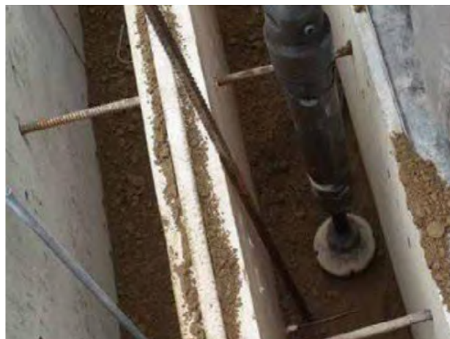
Zdjęcie 8a. Ubijanie ziemi w deskowaniu z izolacją termiczną
