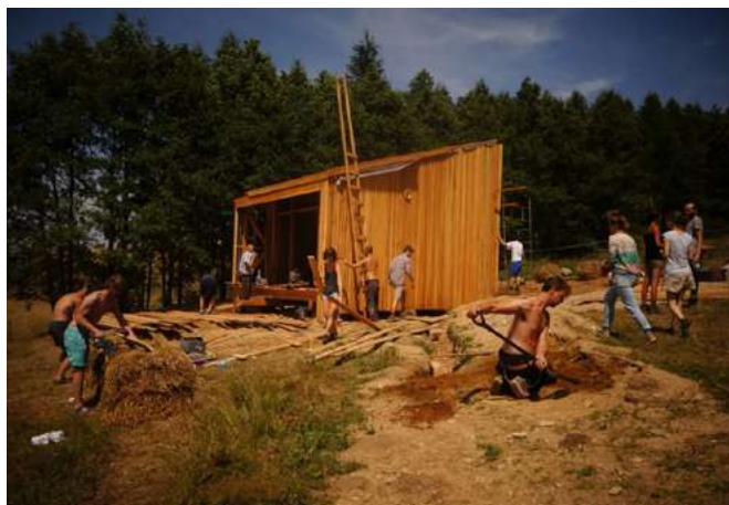
Zdjęcie 1. Budowa domu 35 m 2 metodą gospodarczą/warsztatową
