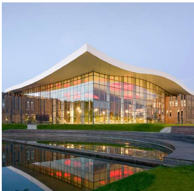
Zdjęcie 5. Budynek Liander, którego dach przykrył kilka istniejących obiektów budowlanych, łącząc je w jeden
