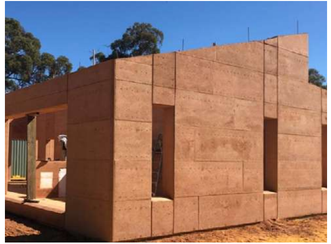
Zdjęcie 4. Przykład nieprefabrykowanych nadproży wykonywanych na budowie podczas wznoszenia ściany z ziemi ubijanej. Szalunki podparto od spodu w trakcie ubijania warstw ziemi ubijanej, pomiędzy nimi układano zbrojenie
