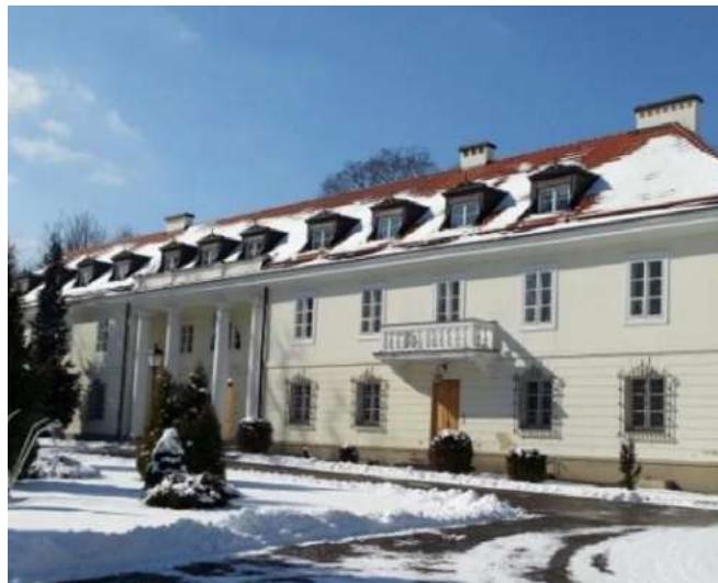
Zdjęcie 6. Pałac Mostowskich na Tarchominie w Warszawie z przełomu XVII i XVIII. Ściany zewnętrzne wykonano z ziemi ubijanej, stabilizowanej wapnem
