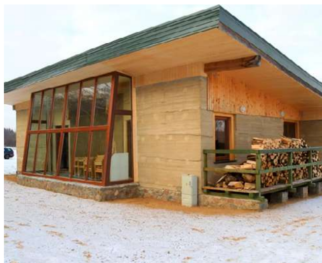
Zdjęcie 9. Budynek z ziemi ubijanej znajdujący się w Pasłęku w Polsce
