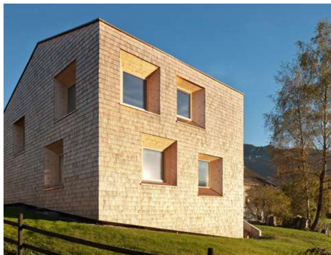
Zdjęcie 5. Dom Simma w Egg (Austria, 2011). Przykład przebudowy i termomodernizacji z użyciem dużych kostek słomy. Proj. Georg Bechter Architektur
