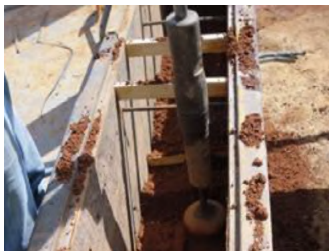
Zdjęcie 2b. Etapy wznoszenia ściany z ziemi ubijanej [9]. Ubijanie warstwy mieszanki ziemi
