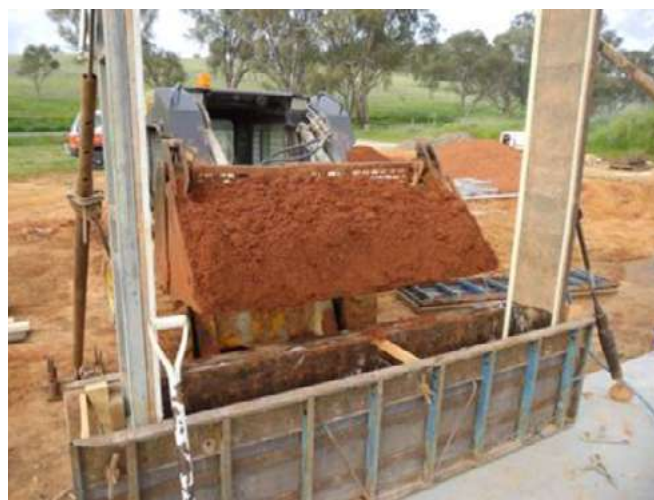
Zdjęcie 2a. Etapy wznoszenia ściany z ziemi ubijanej [9]. Transport wilgotnej mieszanki ziemi w miejsce przygotowanego deskowania
