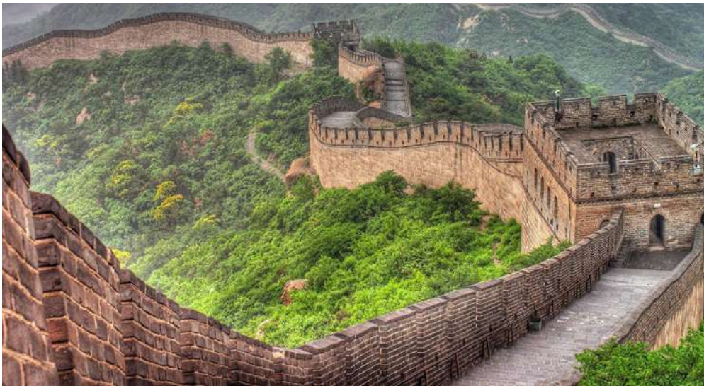
Zdjęcie 4. Wielki Mur Chiński w klimacie umiarkowanym. Główna część muru wykonana z ziemi ubijanej, obłożona z zewnątrz bloczkami z różnych materiałów naturalnych
