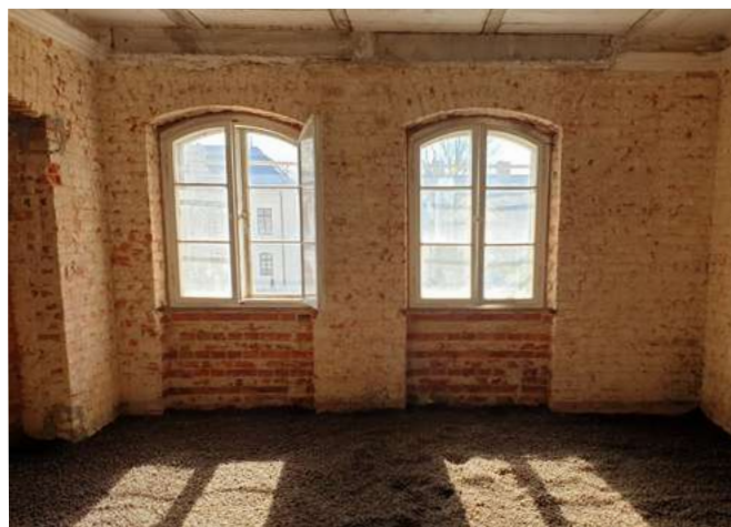
Zdjęcie 3. Izolacja stropu keramzytem
