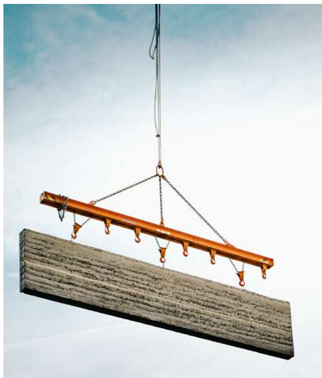
Zdjęcie 19. Prefabrykaty z ziemi ubijanej produkowane w Austrii
