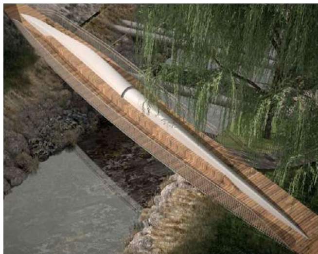
Rysunek 2. Projekt kładki w Szprotawie z użyciem łopaty wiatraka jako elementu nośnego, autor: Agata Kowalczyk
