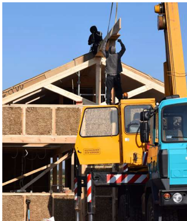
Zdjęcie 3. Montaż prefabrykatów
