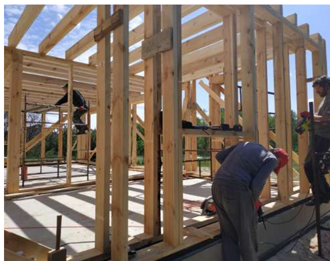
Zdjęcie 1. Budowa szkieletu drewnianego dwugałęziowego przez inwestorów
