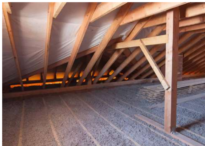
Zdjęcie 5. Docieplenie poddasza celulożą
