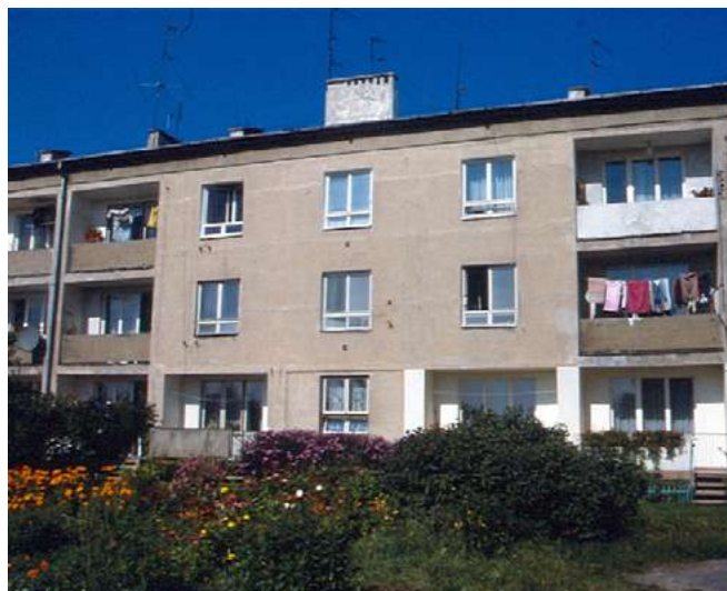
Zdjęcie 8. Budynek mieszkalny w Pruszkowie, wzniesiony w latach 50. XX wieku w technologii ziemi ubijanej
