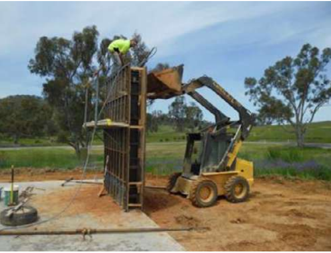
Zdjęcie 2c. Etapy wznoszenia ściany z ziemi ubijanej [9]. Montaż następných deskowań i ubijanie kolejnych warstw ziemi
