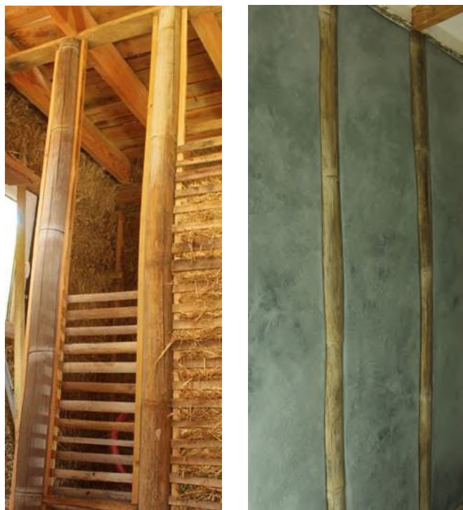
Zdjęcie 3a i 3b. Ścianki działowe (bambus, słoma na ruszcie drewnianym, tadelakt), wyk. Szymon Sarnicki/ Biohabitat NB
