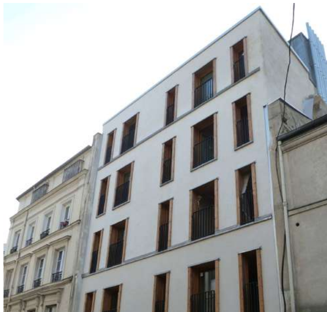
Zdjęcie 1. Sześciokondygnacyjny budynek mieszkalny w Paryżu, 2014. konoplit został użyty jako wypełnienie ścian i dachu. Do budowy zużyto 150 m3 materiału.
