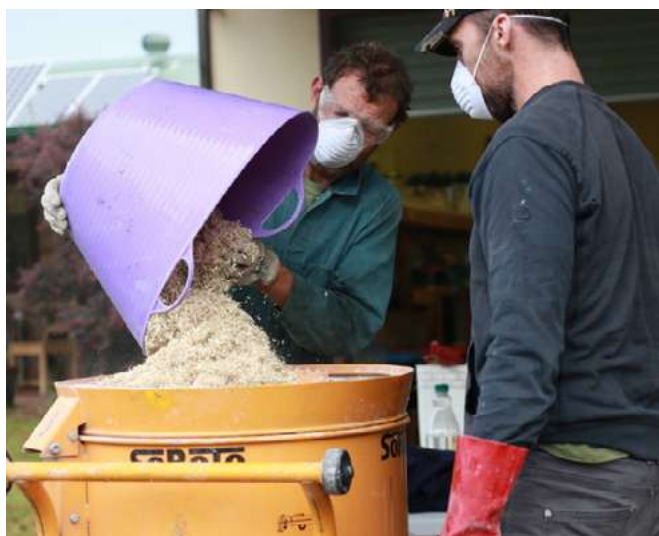
Zdjęcie 1. Przygotowywanie konoplitu
