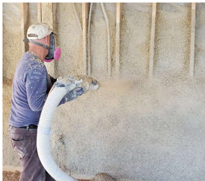
Zdjęcie 11. Natryskiwanie betonu konopnego znacznie przyspiesza pracę.
