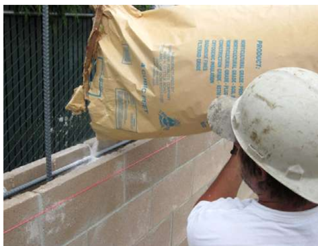
Zdjęcie 2. Zasyp ściany perlitem
