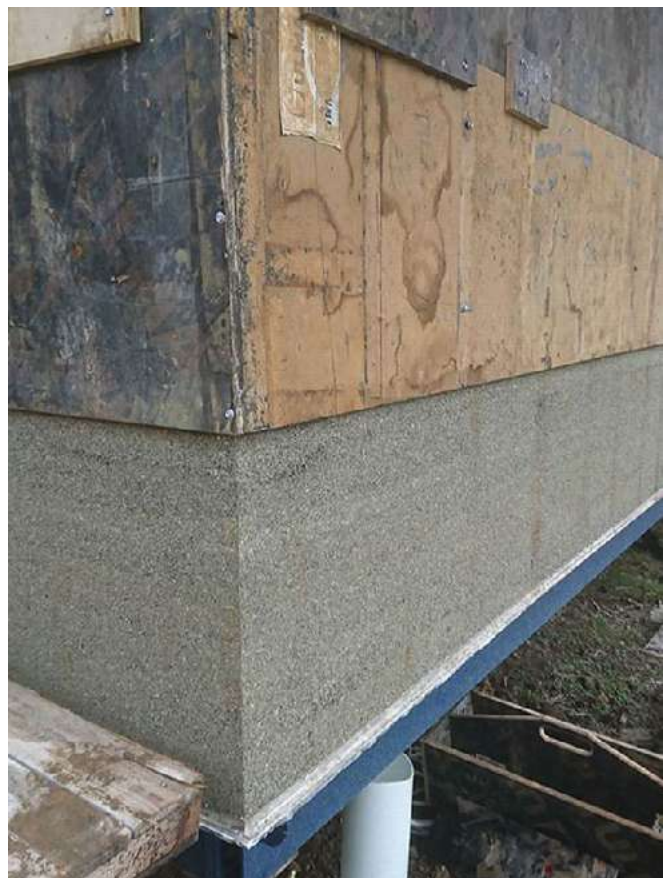
Zdjęcie 4. Szalunek na rogu budynku
