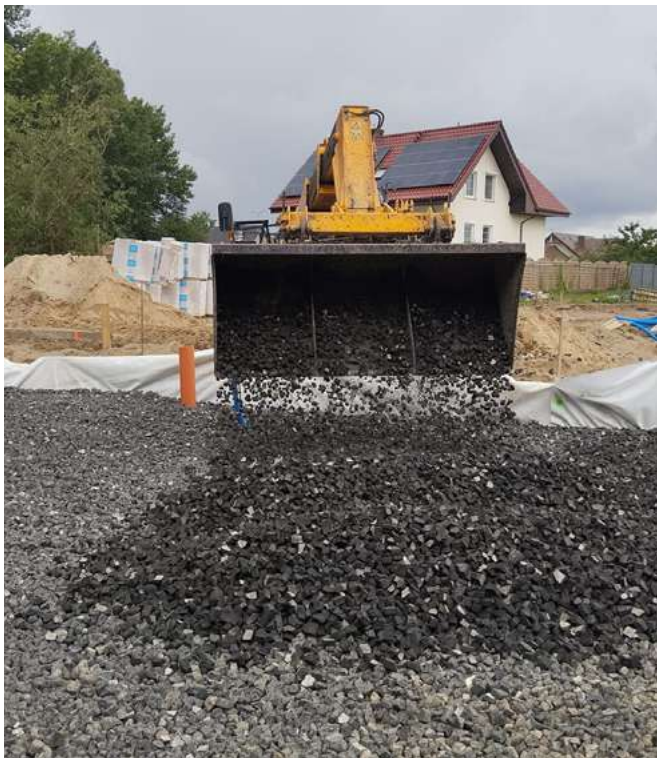
Zdjęcie 4. Izolacja termiczna, drenaż i stabilizacja pod płytą fundamentową
