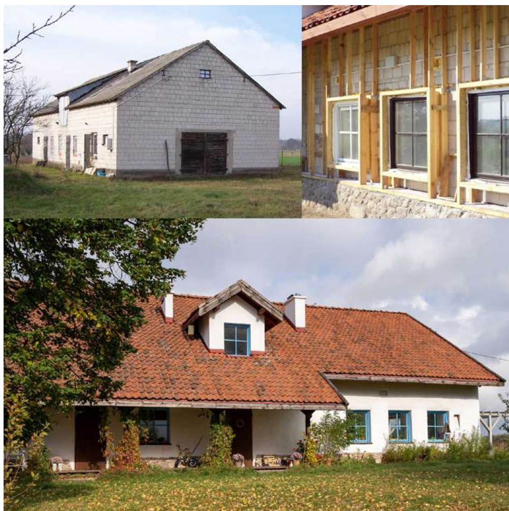
Zdjęcie 6. Przebudowa i termomodernizacja - agroturystyka „Osiedlisko nad Soną” w Spądoszynie. Po lewej na górze: stodoła przed adaptacją. Po prawej na górze: ściana murowana stodoły i lekka konstrukcja drewniana przygotowana do montażu kostek słomy. Budowa 2015. Proj. Janusz Kubiczek.
