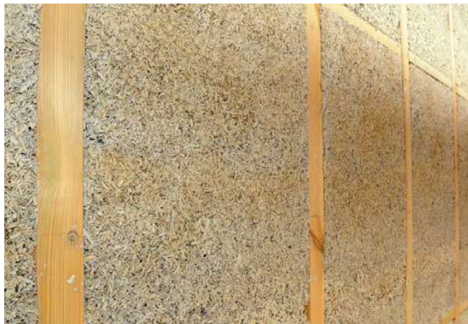
Zdjęcie 2. Gotowa ściana z betonu konopnego oraz drewnianej konstrukcji nośnej
