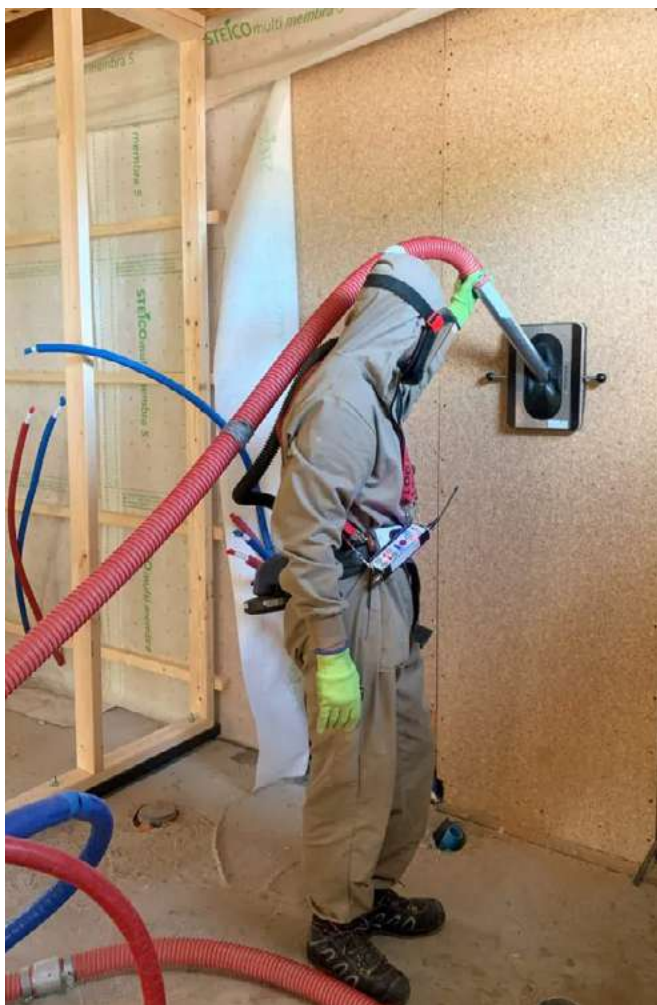
Zdjęcie 8. Wdmuchiwanie włókien drzewnych w ścianę szkieletową
