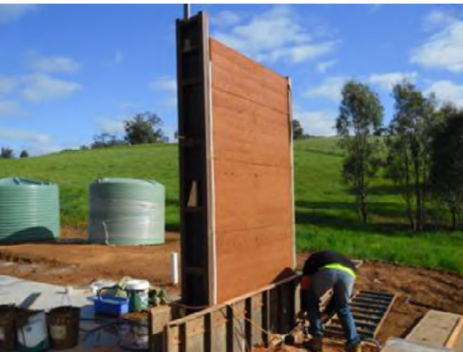
Zdjęcie 2d. Etapy wznoszenia ściany z ziemi ubijanej [9]. Ściana z ziemi ubijanej w trakcie rozformowywania
