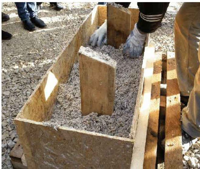
Zdjęcie 10. Rozprowadzanie betonu konopnego wewnątrz szalunku.
