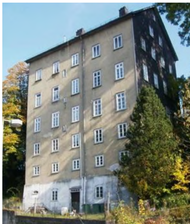
Zdjęcie 3. Budynek mieszkalny z gliny ubijanej, Weilburg, Niemcy
