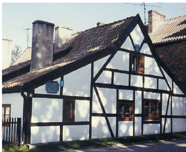
Zdjęcie 7. Dom mieszkalny na Helu z XVII w. Konstrukcja ryglowa, wypełniona masą ziemną i cegłami z ziemi
