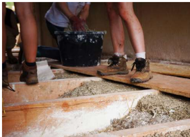
Zdjęcie 6. Docieplenie podłogi podniesionej
