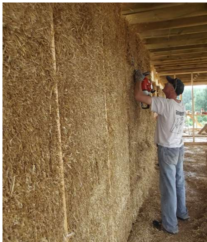
Zdjęcie 2. Strzyżenie za pomocą szlifierki kątowej
