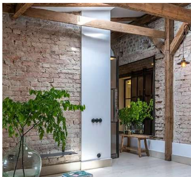
Zdjęcie 21. Połączenie różnych naturalnych wykończeń: rozwodniona farba gliniana na powierzchni cegły, tynk gliniany
