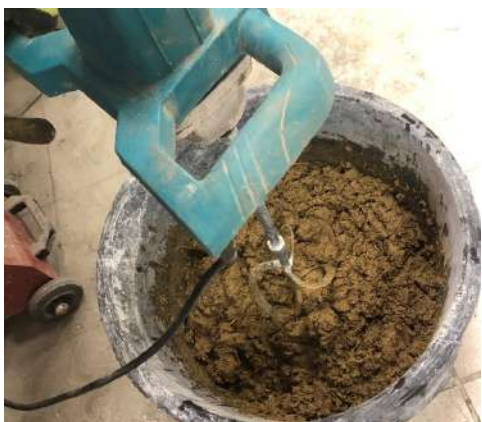
Rysunek 5. Mieszanie gliny lekkiej z wodą
