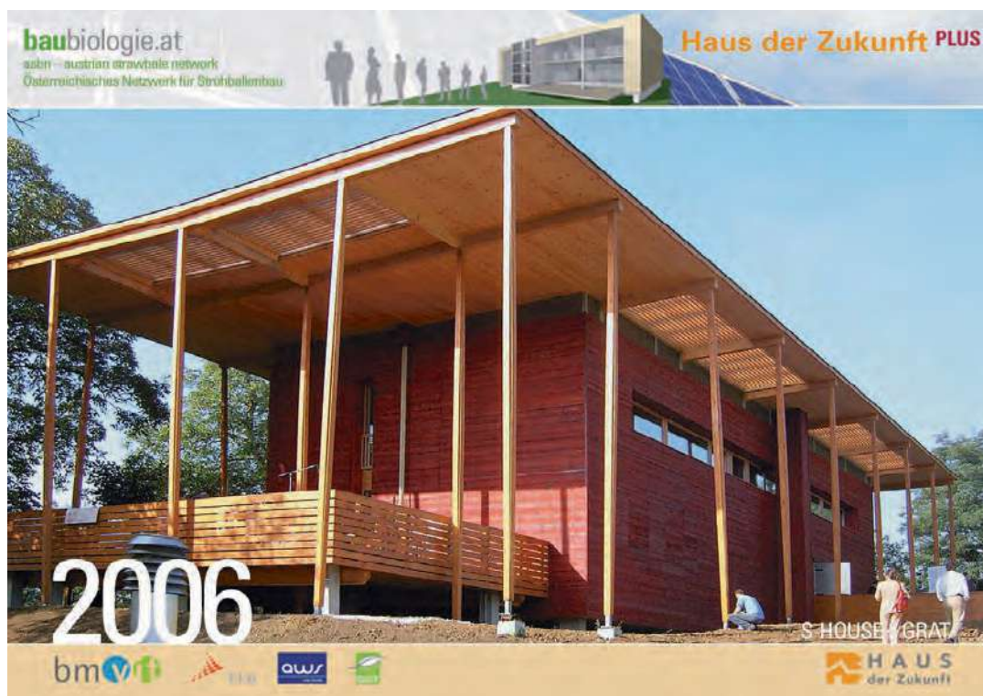
S-House z fasadą z drewna modrzewiowego na wentylowanej ścianie z kostek słomy otynkowanej gliną.
