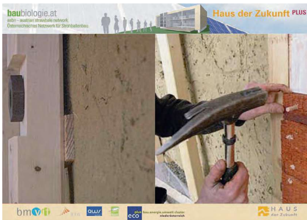
S-House Böheimkirchen (GrAT): Deski z drewna modrzewiowego zostały pokryte olejem (AURO) i przymocowane za pomocą drewnianych kołków.
