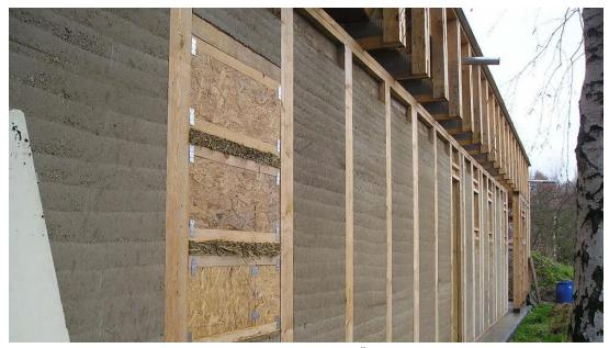
Modern wooden frame structure with clay filling (Source: I. Žabičková, Z. Vejpustek, Kombinace dřeva a hlíny v moderním stavebnictví - novostavby, [hlina.info] online])
