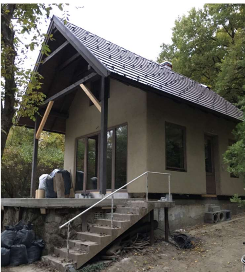
Planowany dom w trakcie budowy (Źródło: NaturARCH Studio)
