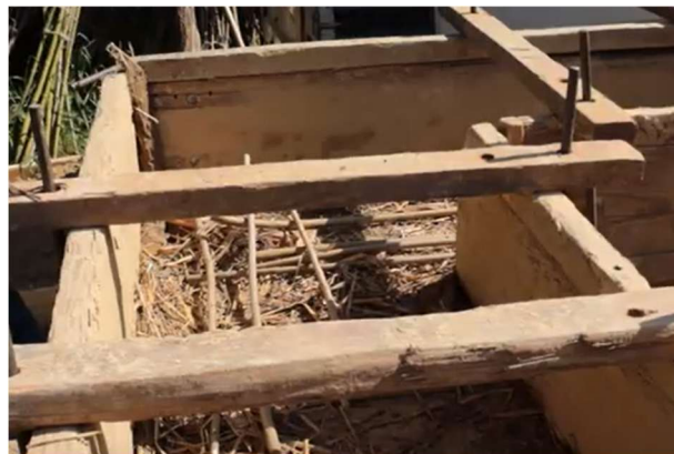
Słoma i gałzki na dnie drugiej warstwy (Źródło: E-Academy of Building Trades (E-Akademia Budownictwa), Környezettudatos Építők Szervezete)
