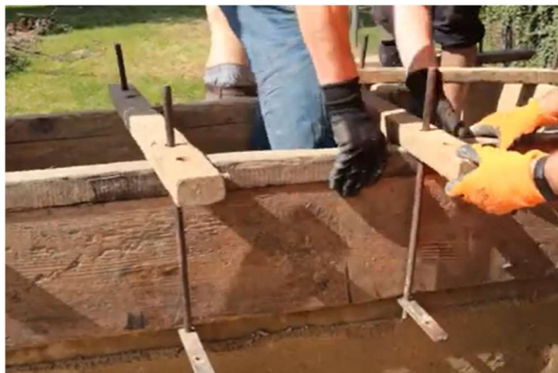
Montaż szalunku dla drugiej warstwy (Źródło: E-Academy of Building Trades (E-Akademia Budownictwa), Környezettudatos Építők Szervezete)
