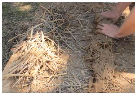
Wykonanie wiązek słomy (Źródło: E-Academy of Building Trades (E-Akademia Budownictwa), Környezettudatos Építők Szervezete)
