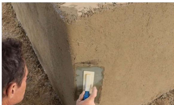
Formowanie lekko zaokrąglonej krawędzi (Źródło: E-Academy of Building Trades (E-Akademia Budownictwa), Környezettudatos Építők Szervezete)
