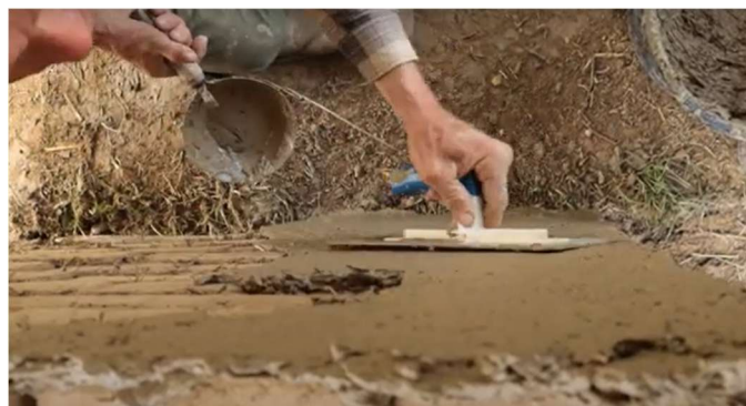
Tynk błotny wygładza się na powierzchni (Źródło: E-Academy of Building Trades (E-Akademia Budownictwa), Környezettudatos Építők Szervezete)
