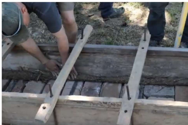
Wypełnianie szczelin (Źródło: E-Academy of Building Trades (E-Akademia Budownictwa), Környezettudatos Építők Szervezete)
