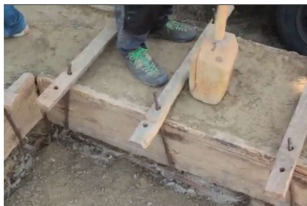
Trzecia warstwa ubijanej gliny (Źródło: E-Academy of Building Trades, Környezettudatos Építők Szervezete)
