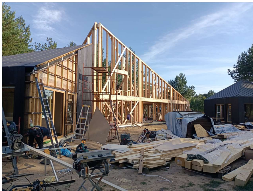
Konstrukcja drewniana (Zdjęcie: Paweł Wołęjsza)
