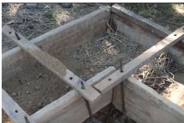
Cienka warstwa słomy (Źródło: E-Academy of Building Trades (E-Akademia Budownictwa), Környezettudatos Építők Szervezete)
