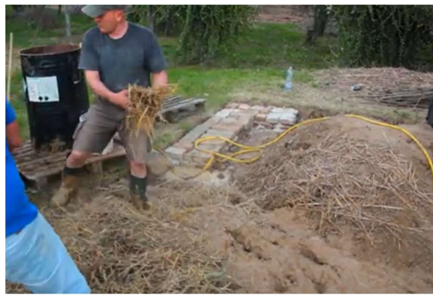
Dodawanie słomy (Źródło: E-Academy of Building Trades (E-Akademia Budownictwa), Környezettudatos Építők Szervezete)
