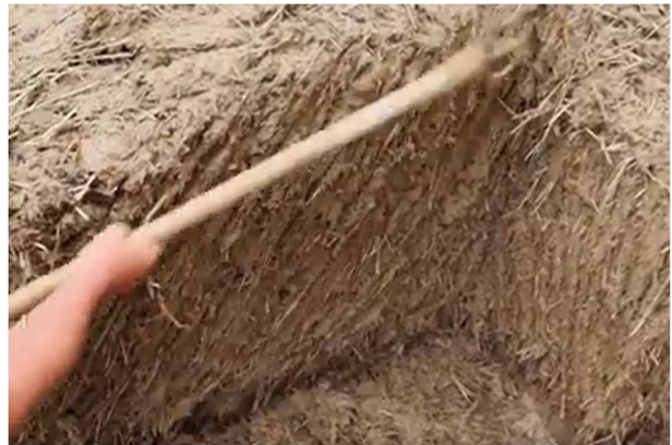
Wyrównanie krawędzi ściany (Źródło: E-Academy of Building Trades (E-Akademia Budownictwa), Környezettudatos Építők Szervezete)
