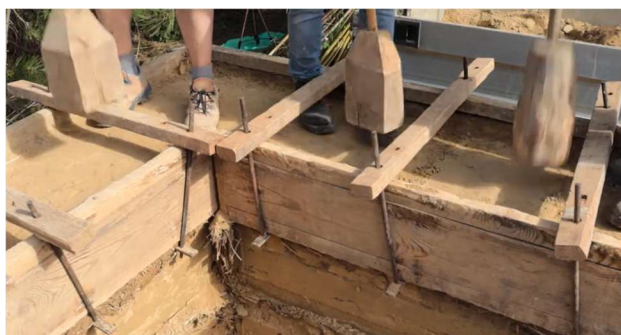
Ubijanie drugiej warstwy (Źródło: E-Academy of Building Trades (E-Akademia Budownictwa), Környezettudatos Építők Szervezete)
