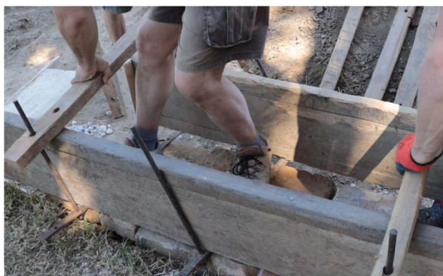
Montaż szalunku (Źródło: E-Academy of Building Trades (E-Akademia Budownictwa), Környezettudatos Építők Szervezete)
