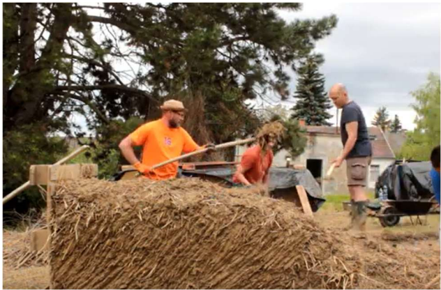
Budowa ściany (Źródło: E-Academy of Building Trades (E-Akademia Budownictwa), Környezettudatos Építők Szervezete)
