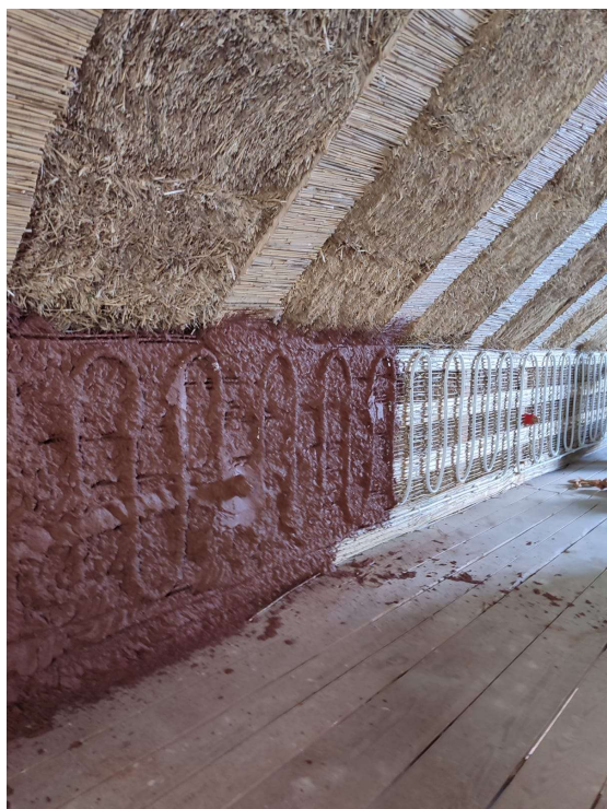
Ogrzewanie w ścianie (Zdjęcie: Marta Rudyk)
