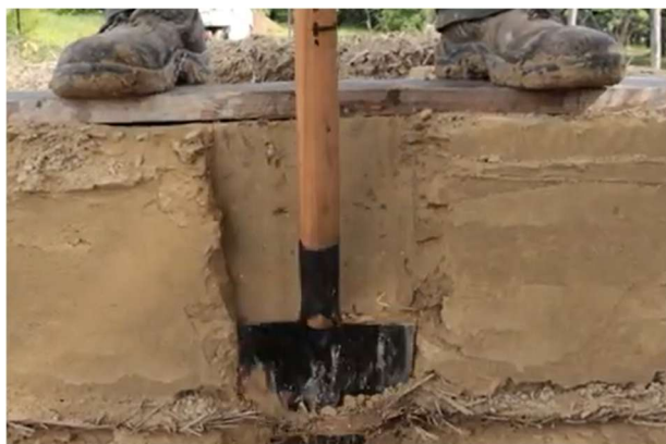
Cięcie powierzchni (Źródło: E-Academy of Building Trades (E-Akademia Budownictwa), Környezettudatos Építők Szervezete)
