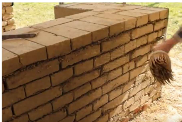
Przygotowanie ściany ceglanej (Źródło: E-Academy of Building Trades (E-Akademia Budownictwa), Környezettudatos Építők Szervezete)
