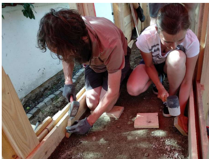
Kolumbarium – proces budowy [Autor: Mária Pružincová, SHS z.s.)
