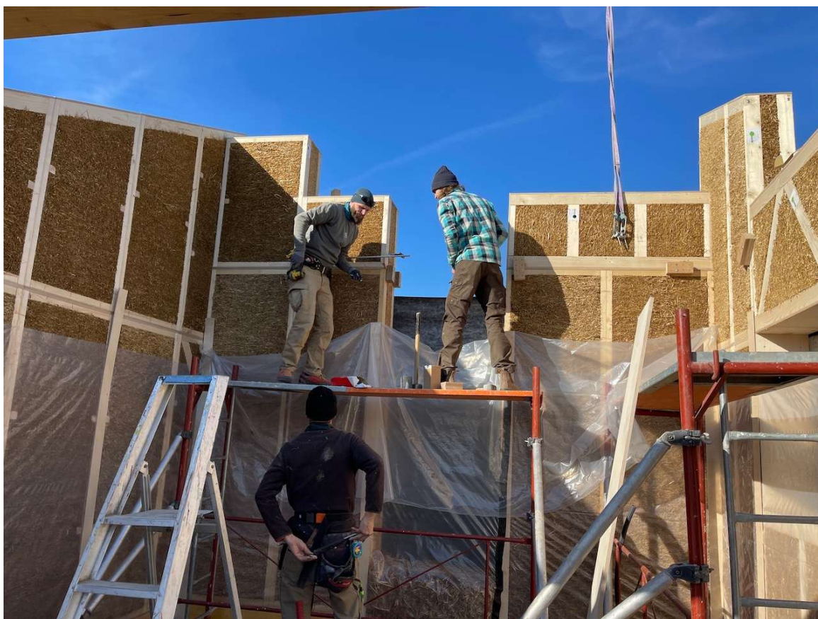
Mały domek – proces budowy (Zdjęcie: ArTUR)
