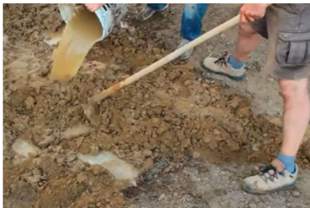
Przygotowanie gliny (Źródło: E-Academy of Building Trades (E-Akademia Budownictwa), Környezettudatos Építők Szervezete)
