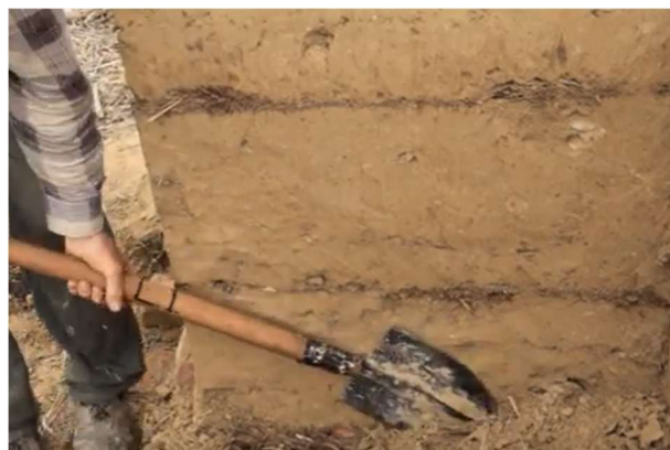
Szlifowanie powierzchni ściany (Źródło: E-Academy of Building Trades (E-Akademia Budownictwa), Környezettudatos Építők Szervezete)
