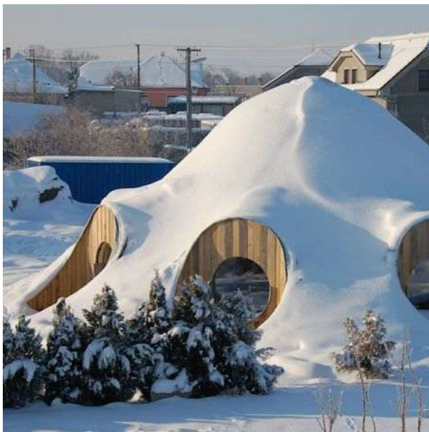
Samonośna kopuła ze słomianych kostek (Zdjęcie: Createrterra Architectural Studio)
